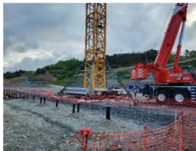
Grue principale et réseaux sous dallage
