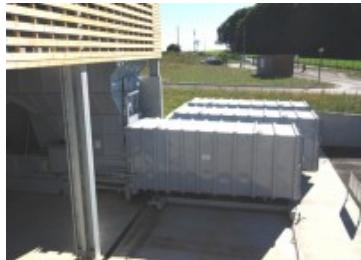
3. Les déchets compactés sont dirigés automatiquement dans un caisson à compaction.
