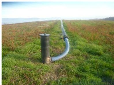
Dans le cadre de la prestation de réglage du réseau de captage du biogaz, l'entreprise effectue un contrôle du réseau (point bas, raccord réseau ...).
