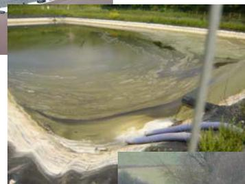
Appelées **lixiviats**, les eaux ayant percolé à travers les déchets sont collectées à l'aide d'un drain en fond de casier.
