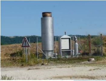
La dégradation des déchets produit du **biogaz** principalement composé de méthane.
