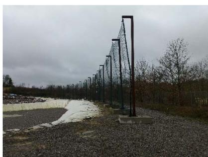
Des filets anti envols ont été mis en place le long de la rocade d'une hauteur de 6 m sur une longueur de 96 m.
