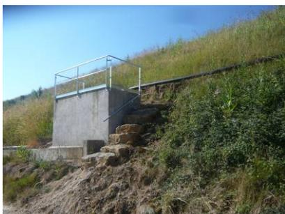
Suite à l'accident survenu le 12 mars 2014 (chute d'un agent lors de l'intervention sur le regard), des travaux de mise en sécurité ont été engagés en juin 2014 : garde corps, modification et allègement des trappes de visite ...).
