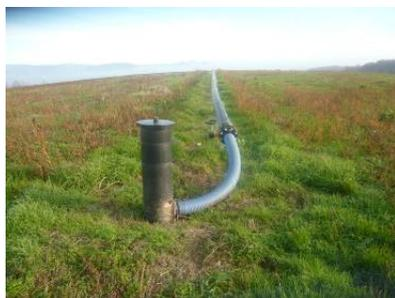
Dans le cadre de la prestation de réglage du réseau de captage du biogaz, l'entreprise effectue un contrôle du réseau (point bas, raccord réseau – puits débranché ...).
